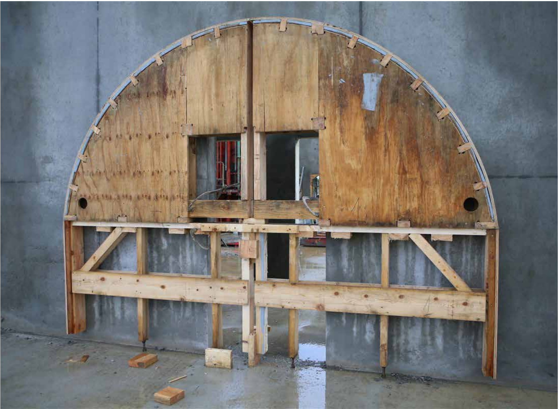
Novembre 2018 Pour que les arches de la Bastide soient parfaites, des coffrages sur mesure ont permis leur coulage en place.
